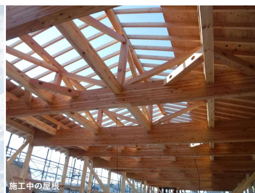
施工中の屋根
