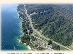
三陸沿岸道路 (岩手県山田町)
