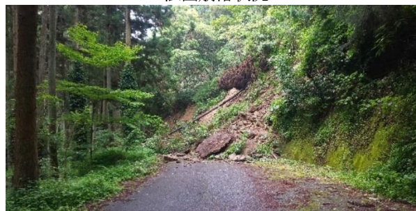
法面崩落状況
