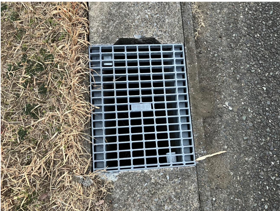
対応後（グレーチング設置後）
