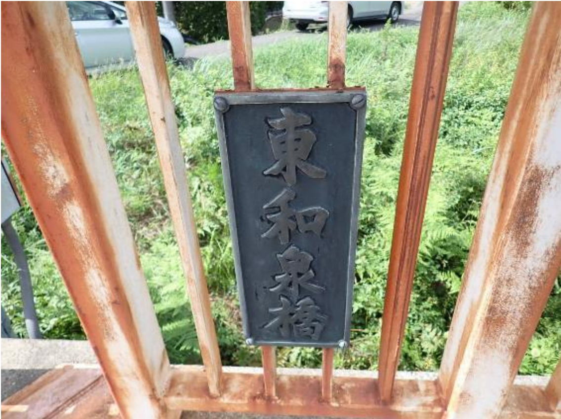
発生場所②（盗難発生前）
