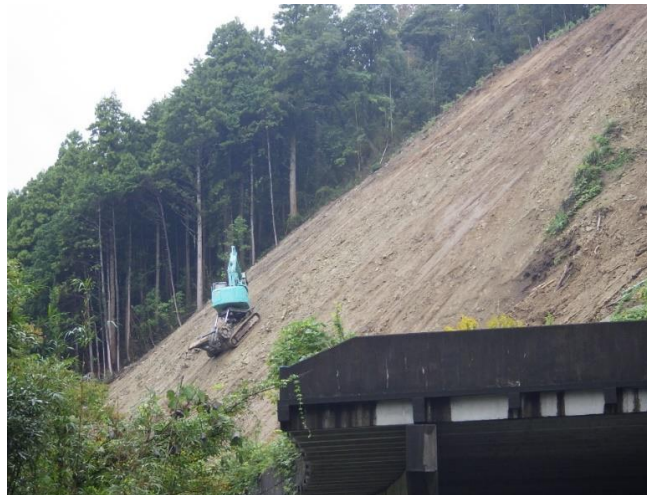
法面掘削機による排土（9月～12月）
