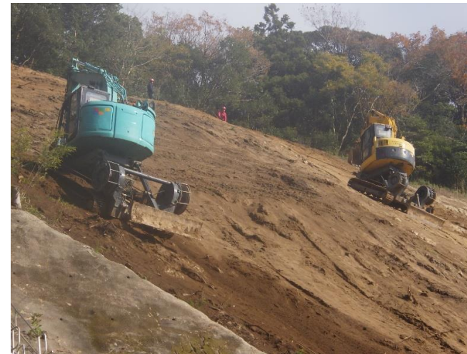
法面掘削機による排土（9月～12月）
