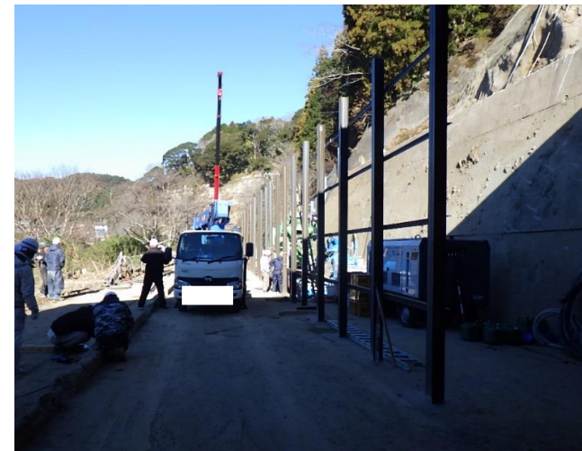
仮設防護柵の設置 (12月)
