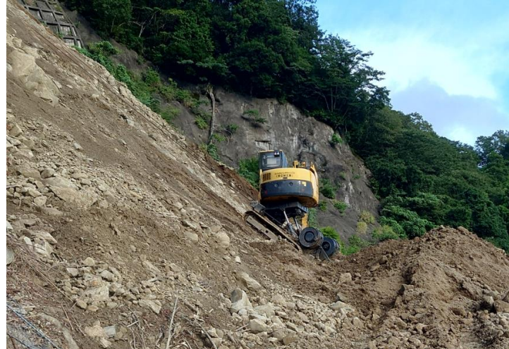
法面掘削機による排土（9月～12月）
