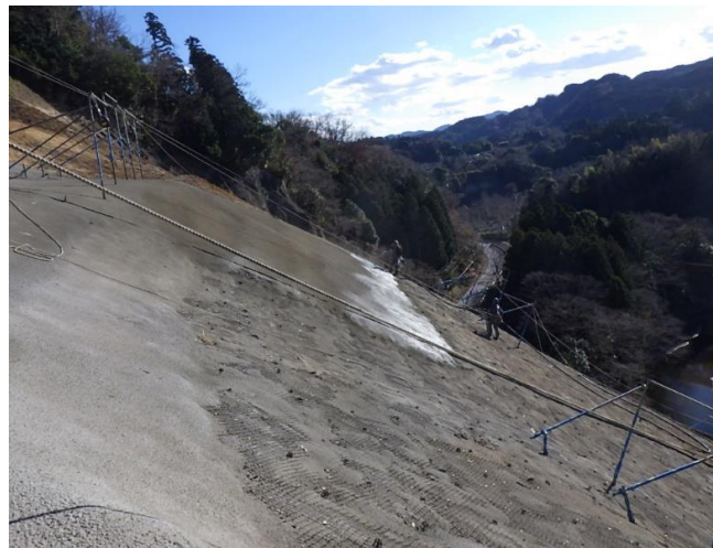
モルタル吹付 (12月)
