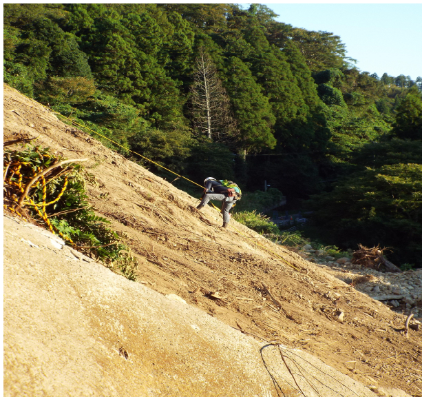
弾性波探査状況
