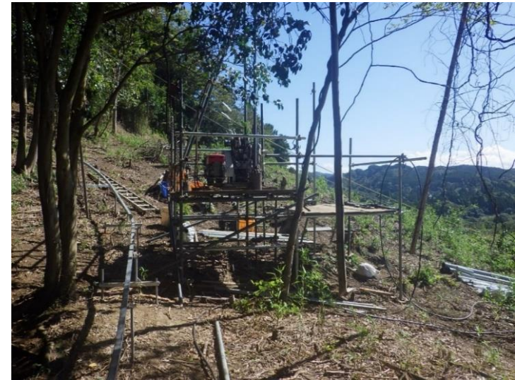
機械ホーリング 状況
