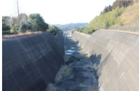
非常用洪水吐導流部
