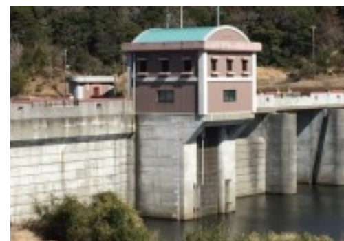
取水設備 貯水池から水を取り入れる設備
