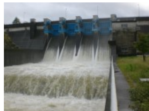
下流からの眺め（防災操作時）
