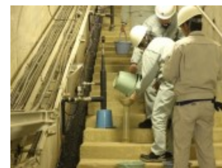
月に一度行われる監査廊での漏水点検
