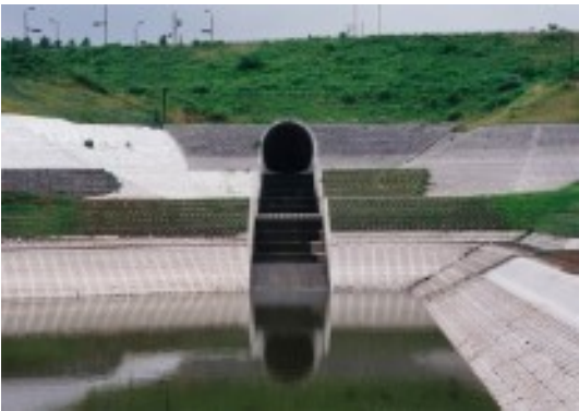
導水路からの放流部
