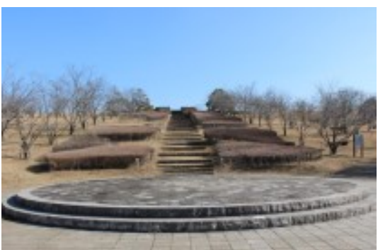
堤体下流より天端を望む
