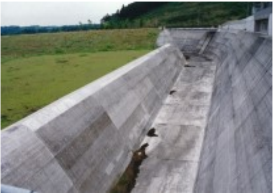
非常用洪水吐越流部
