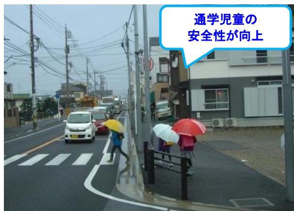
▲歩道整備箇所（2工区）
