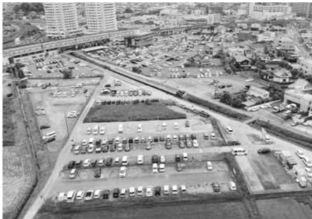
二級河川南白亀川水系小中川 大網白里市（大網駅上流側）
