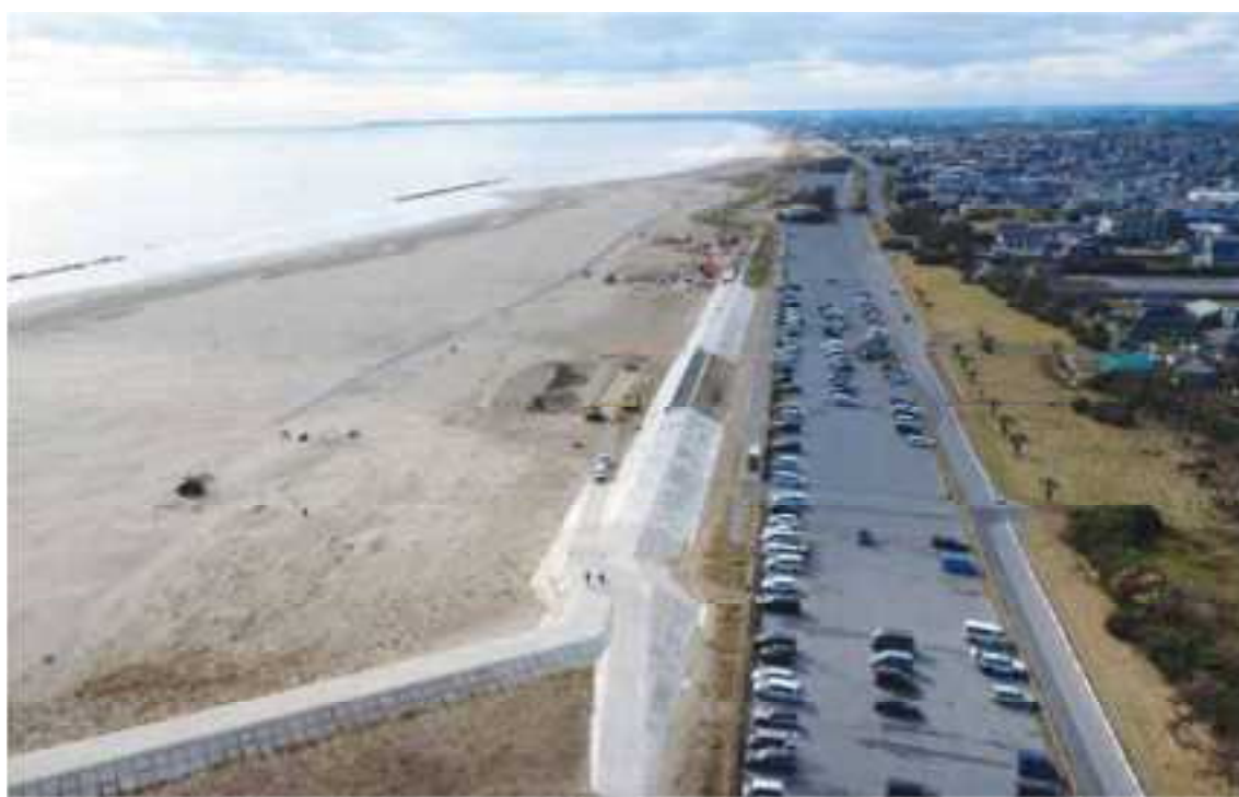
九十九里・南九十九里二号地区海岸（片貝海岸） 粘り強い構造の海岸堤防
