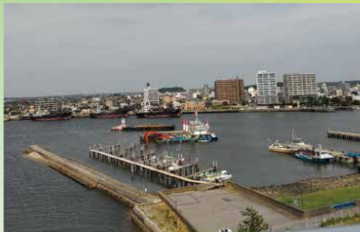
木更津港 吾妻地区（浚渫工事）
