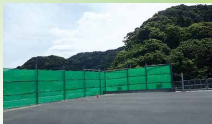
浜金谷港 金谷地区（防砂ネット工事）
