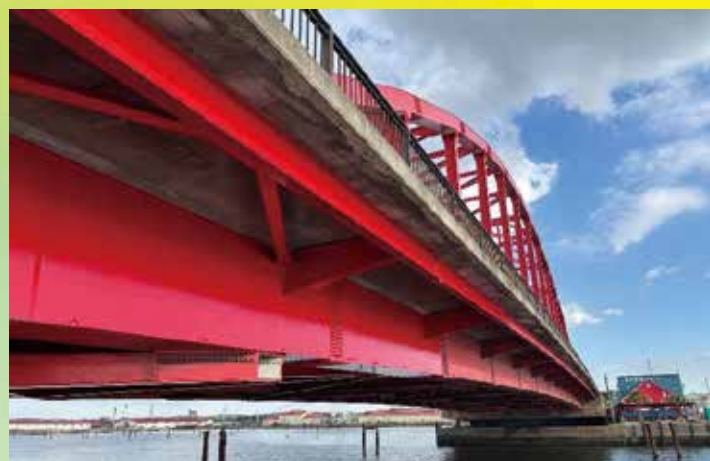
木更津港 木更津南部地区（橋梁工事）
