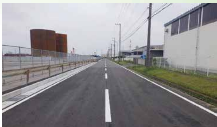
木更津港 富津地区（舗装工事）
