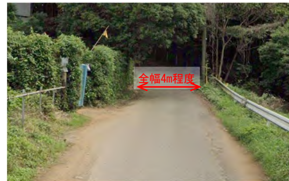
県道 船橋松戸線 道路状況写真 【混雑度について】
