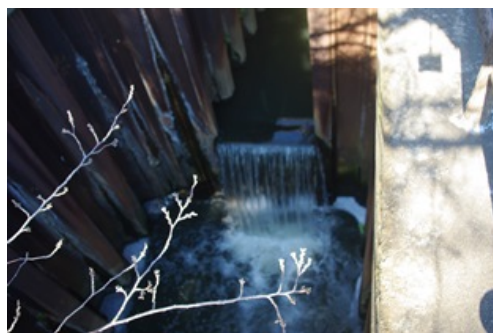
長津川上流区間にある落差工
