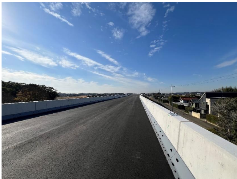
一般国道126号 笹曽根橋
