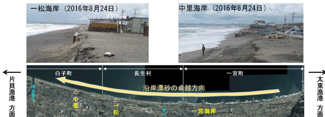
図-3.7 ヘッドランド群（一宮海岸）の沿岸漂砂下手側にあたる一松海岸・中里海岸の侵食状況
