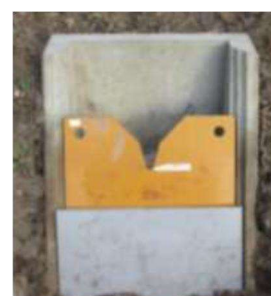
田んぼダムで使用する堰板の例
