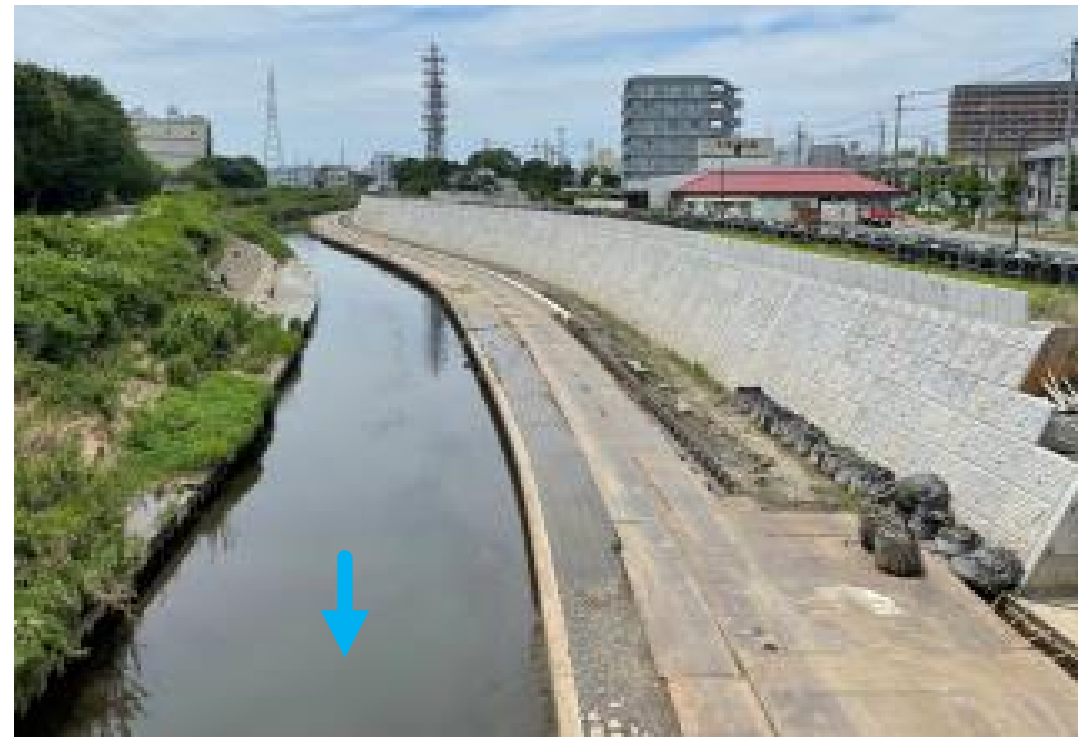
施工中 （令和6年7月撮影）
