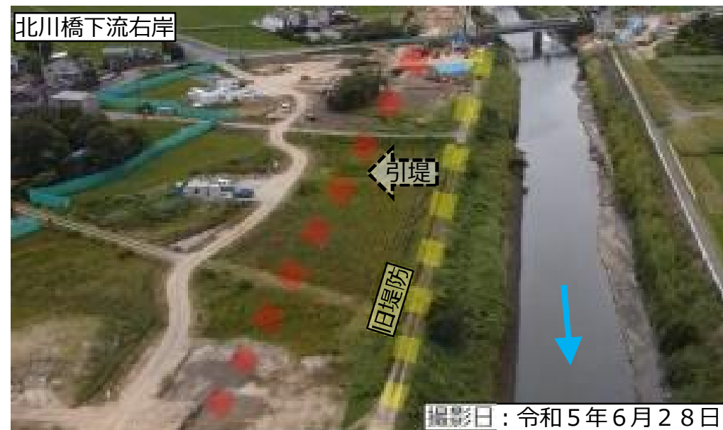
【掘削及び築堤前】
