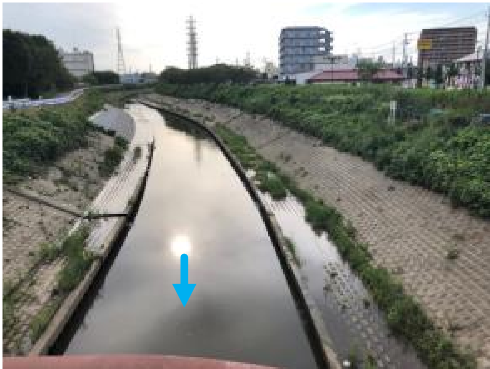
着工前 （令和3年7月撮影）
