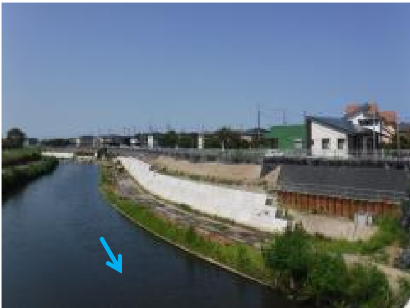
③令和5年7月末（護岸構築～鋼矢板土留引抜）
