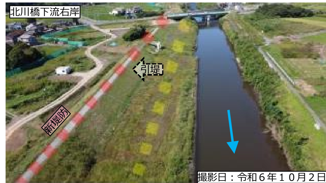
【掘削及び築堤後】
