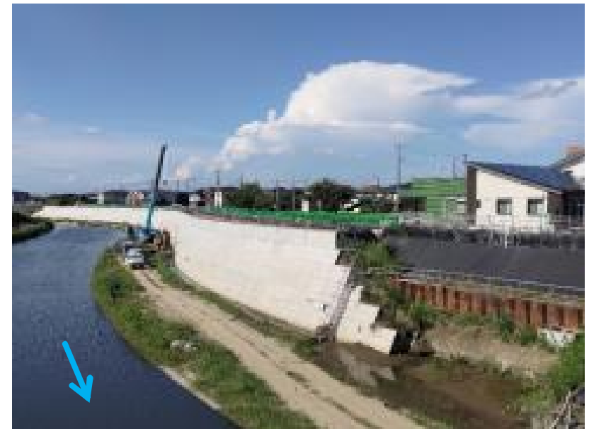
④令和6年7月末（護岸構築）
