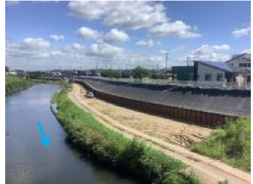
②令和4年7月末（掘削～鋼矢板土留設置）
