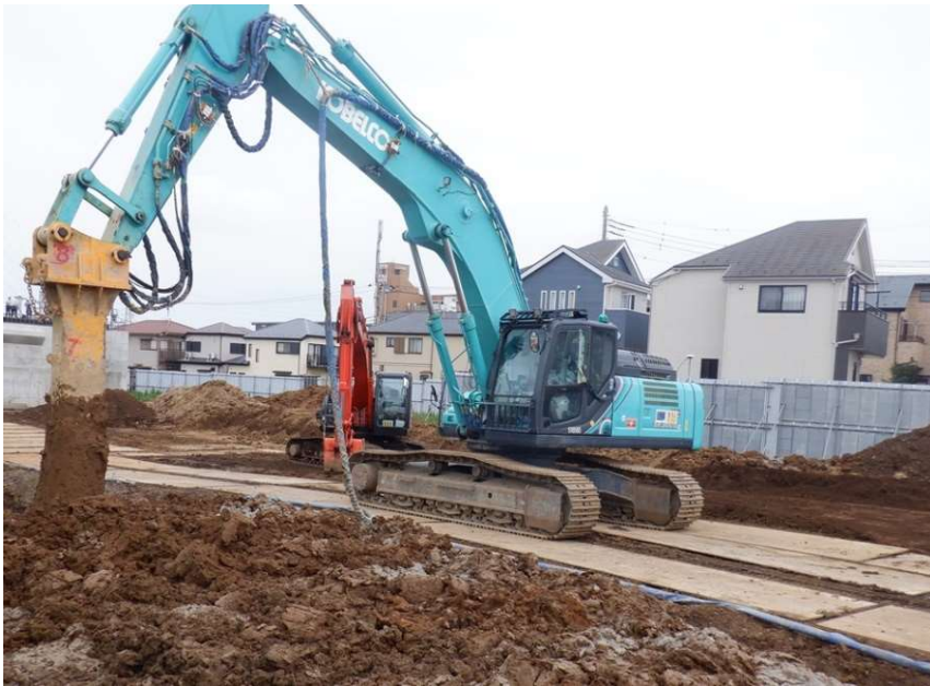
鷺沼側 地盤改良工事 (令和7年6月撮影)
