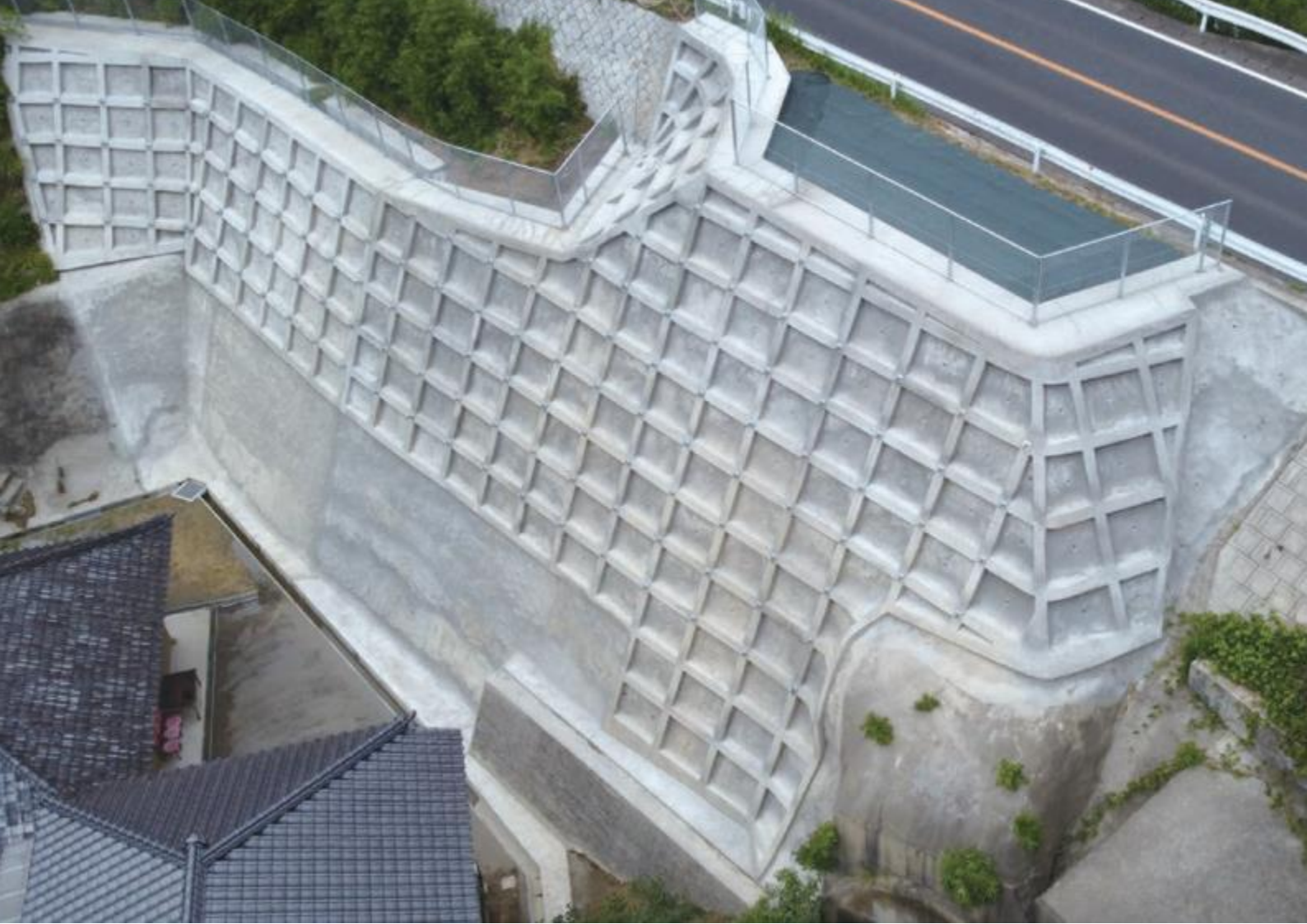
急傾斜地崩壊危険区域(小食土町)
