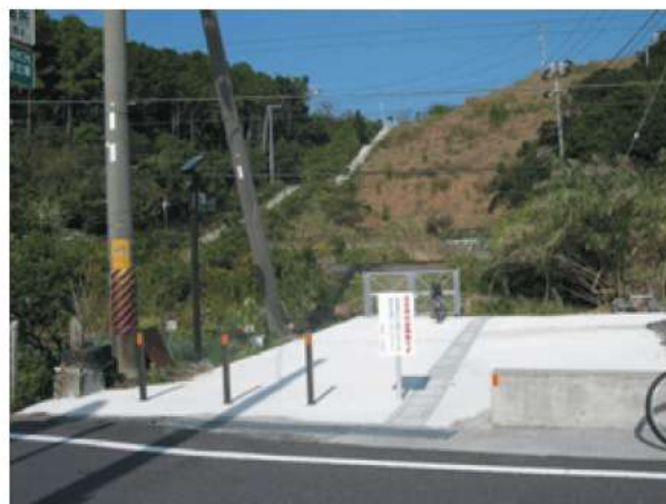
避難路入口の広場
