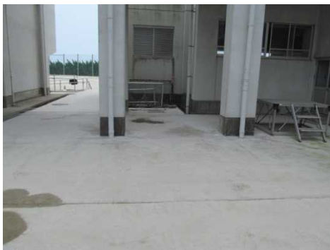
同所の復旧状況
