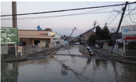
写真 1-3-3 (57 ページ) 泥水が噴出し電柱が傾いた。 (我孫子市布佐地区：我孫子市提供)
