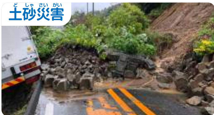
大雨によりくずれたしゃ面
