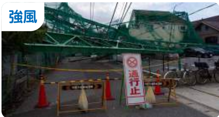
強風により飛ばされた鉄柱
