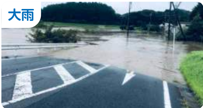
道路にあふれた雨水
