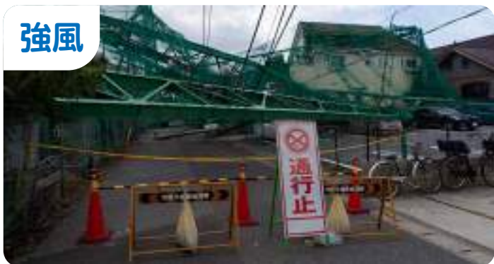
強風により飛ばされた鉄柱
