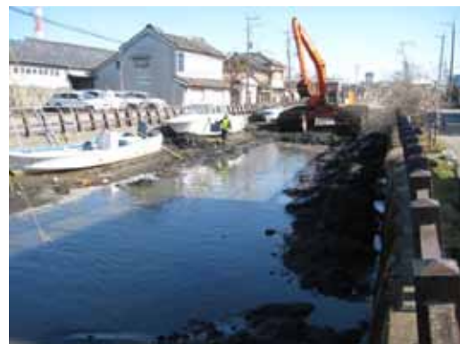
写真3-4-6 (一)小野川 河道掘削
