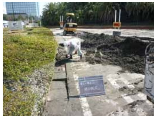
写真 3-4-12 幕張海浜公園 噴砂撤去
