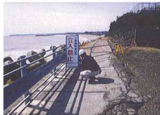
写真 3-4-8 和泉浦海岸 バリケード設置
