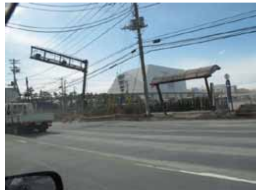
写真 3-4-14 傾いたバス停と電柱等（浦安市）
