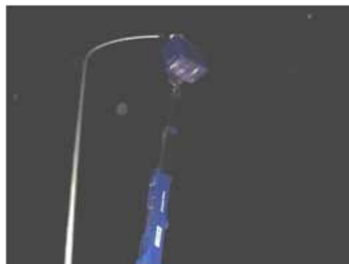
写真 3-4-11 (一)松戸三郷線 照明灯灯具撤去
