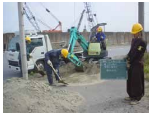
写真 3-4-1 土砂撤去 葛南港湾事務所
