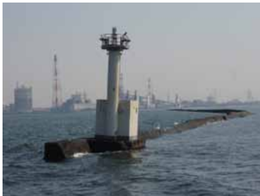
写真 3-4-9 堤防の沈下（被災状況）
