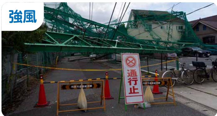
強風により飛ばされた鉄柱
