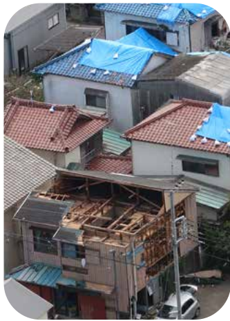
強い風で飛ばされた屋根
