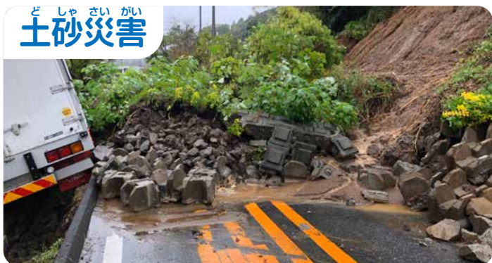
大雨によりくずれたしゃ面
