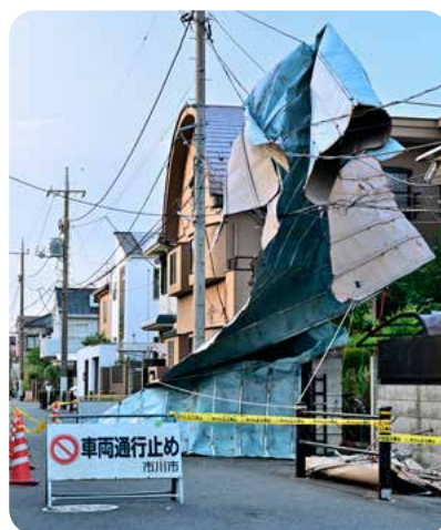
飛ばされたトタン屋根
