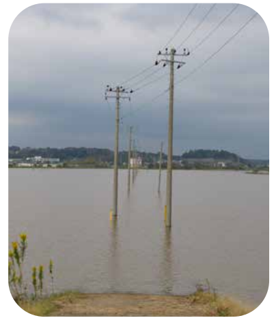
大雨により水位が上がった河川
