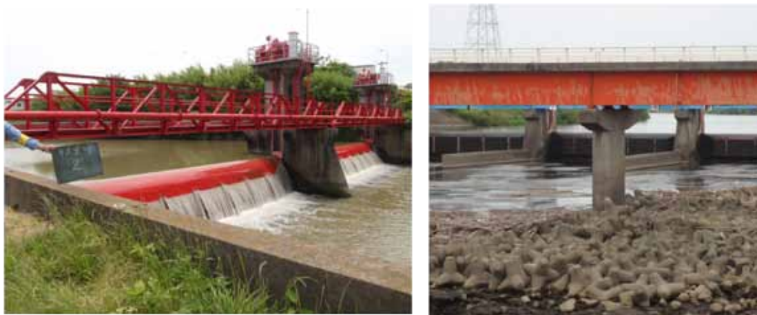
写真 1-2-1 河川遡上を止めたと思われる構造物例 (左：水門（平久里川）、右：堰（小櫃川）)
