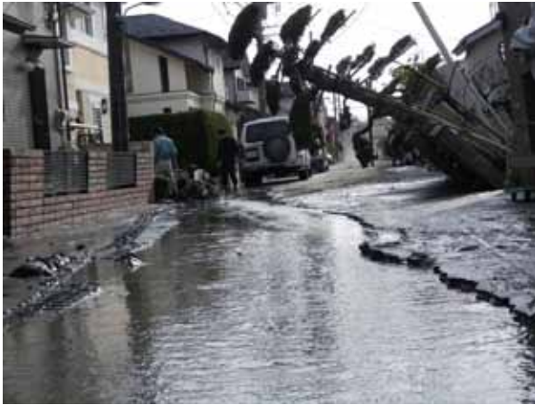
写真 1-3-4 泥水で道は覆われ、塀や植栽が傾く (浦安市舞浜：浦安市消防本部提供)
