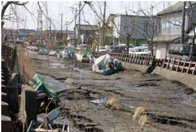
写真 1-3-2 液状化により川底が隆起している (小野川：香取市提供)
