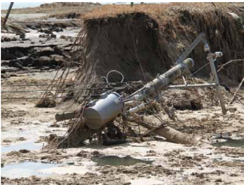
写真 1-2-6 津波により倒された 電柱 （山武市蓮沼：山武市提供）
