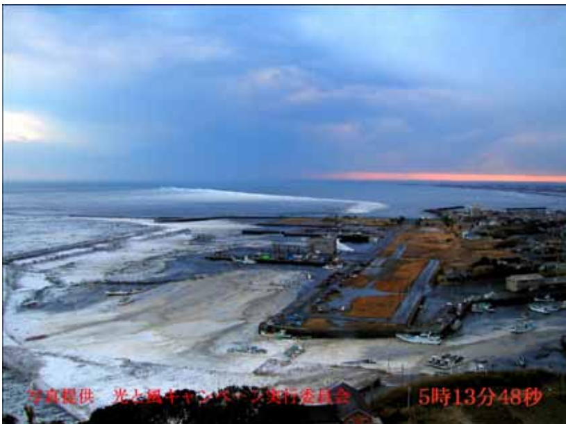
写真 1-2-3 旭市に押し寄せる 津波(飯岡刑部岬から撮影)
