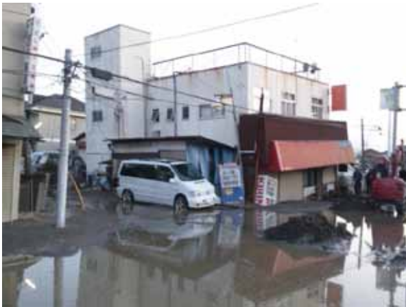
写真 1-3-6 家屋や電柱等の沈み込み (我孫子市布佐地区：我孫子市消防本部提供)
