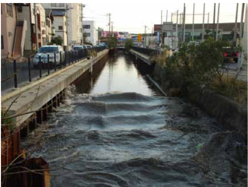
写真 1-2-4 水路を遡上する津波 (銚子市提供)
