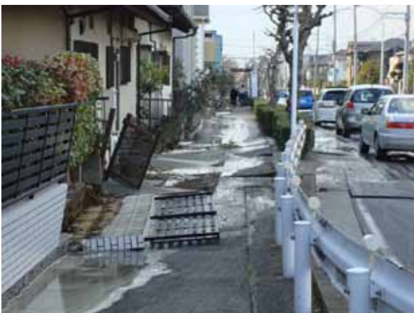
写真 1-3-8 道路は隆起し、塀は倒壊 (習志野市香澄：習志野市提供)
