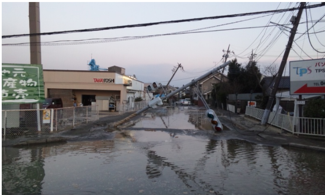
写真 1-3-3 泥水が噴出し電柱が傾く (我孫子市布佐地区：我孫子市提供)
