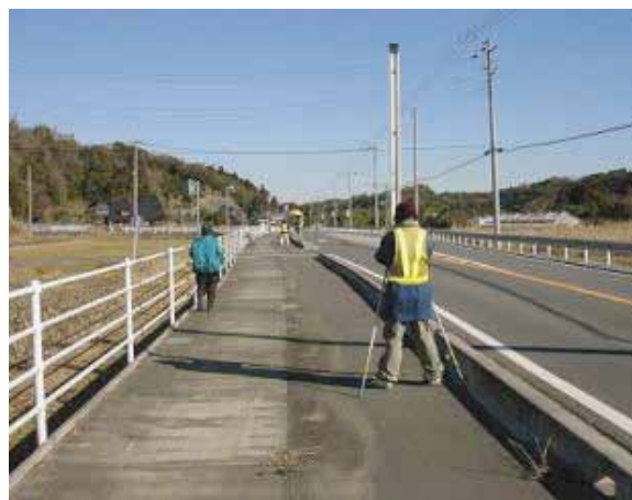
写真1-1-1 水準測量の実施状況
