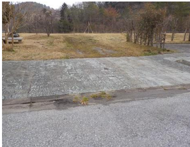
施設への出入口の状況
