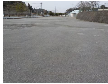
施設内広場等の状況
