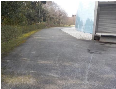
施設への出入口の状況
