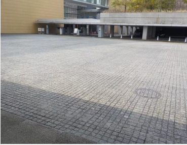
施設への出入口の状況
