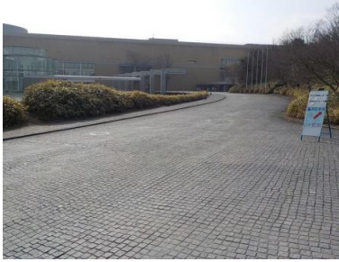
施設への出入口の状況
