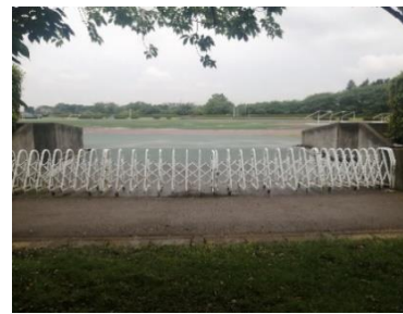
施設への出入口の状況 (駐車場<2>側)
