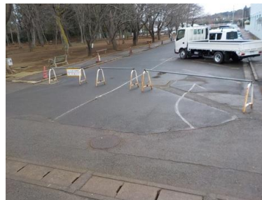
体育館北側の通路 (陸上競技場側から入口方向)
