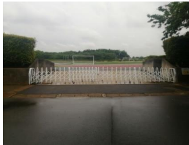
施設への出入口の状況 (出入口①側)
