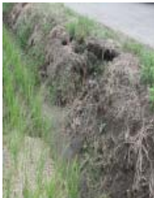
除草剤による管理で崩れた畦畔法面
