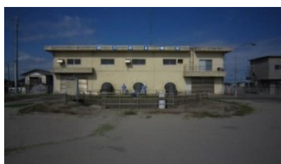
堀川排水機場(全景)
