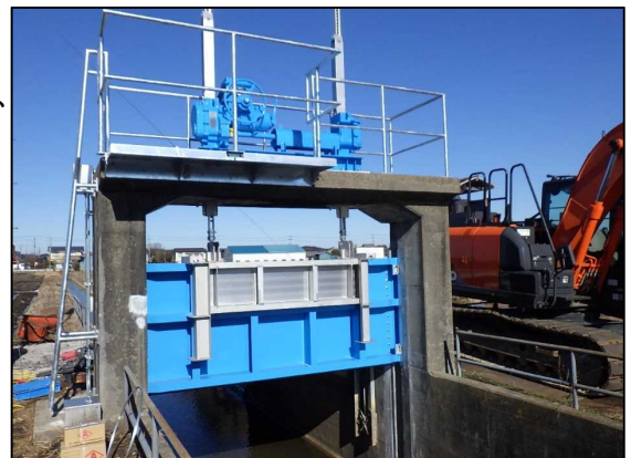
老朽化した水門の更新
