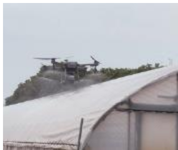
ドローンで塗布材を塗布する様子
