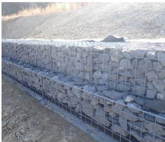
地すべり対策実施後の様子
