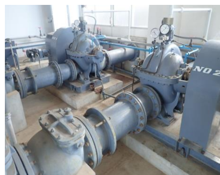
改修予定のポンプ設備
