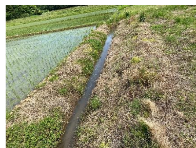
現状の排水路（土水路）
