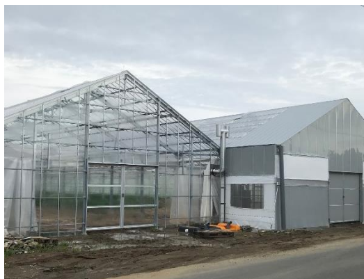
園芸生産施設
