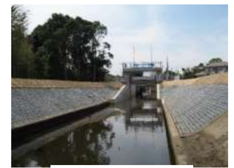
農業水利施設
