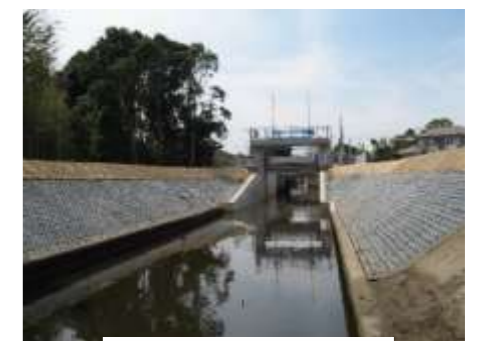
農業水利施設
