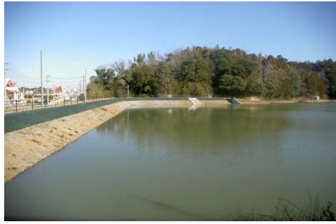
(対策工事した防災重点農業用ため池)
