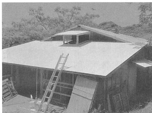
遮熱塗料施工中の牛舎屋根
