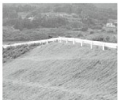
センチピートグラスで覆われた広い法面（鴨川市下小原）
